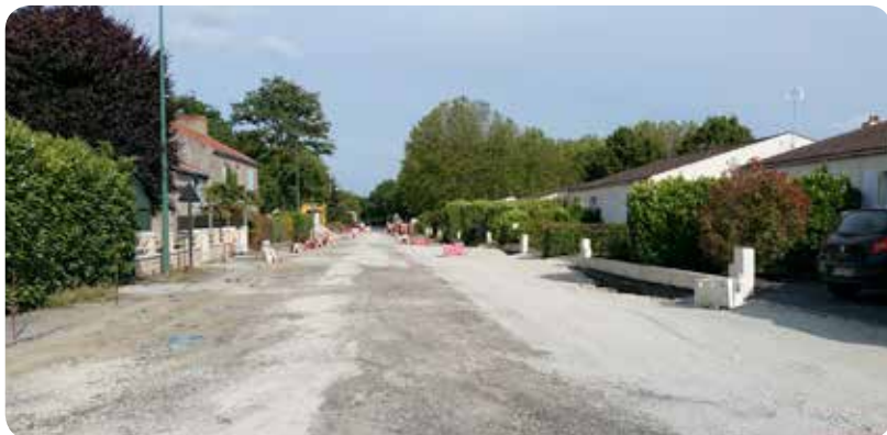
Travaux en de réfection en cours rue Beau Soleil
