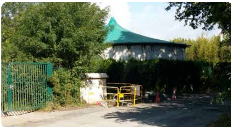
Station d'épuration avant travaux
