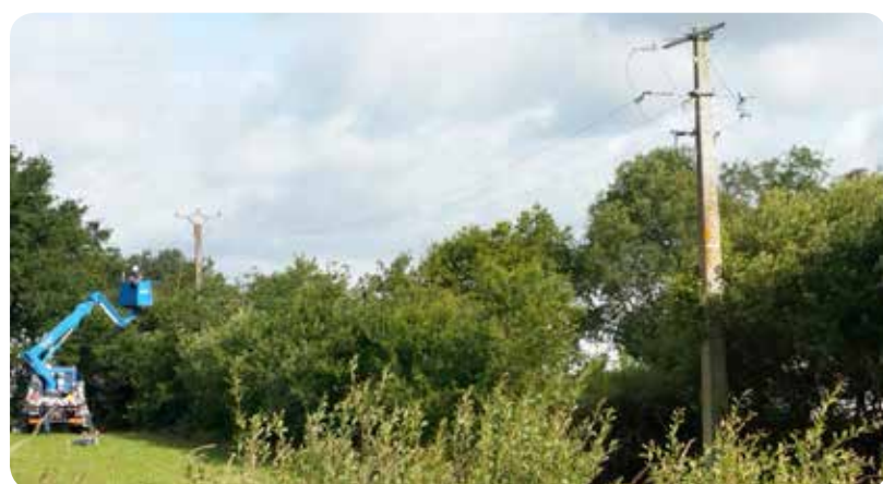
Déplacement de la ligne moyenne tension
