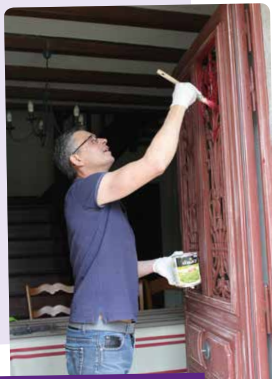
Rafraîchissement peinture des portes des gîtes
