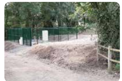
Poste de relevage
