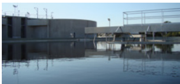
Station épuration - Montaigu-Vendée (Saint-Hilaire-de-Loulay)
